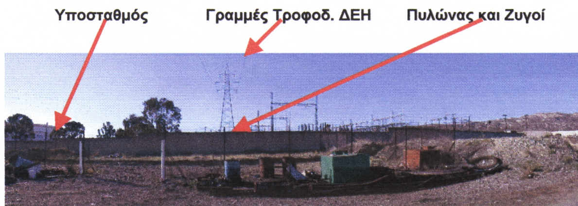
Φωτο. 2. Θέση Υποσταθμού
