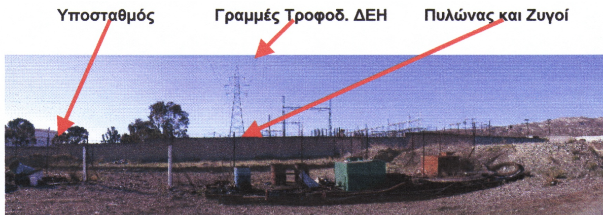
Φωτο. 2. Θέση Υποσταθμού
